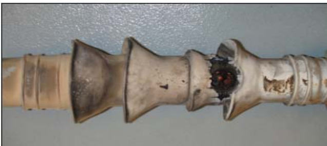
Imagen visual terminal 33kv
